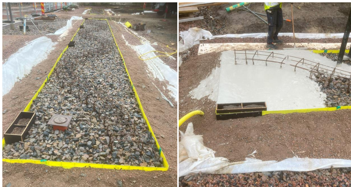
Figur 3.2 Grund av cementbunden makadam till tegelkonstverk, Malmö, april 2024. Vänster – makadamlager i en tjocklek av 180 millimeter; höger – infiltrering med lättflytande bruk. Beställare, Region Skåne; konstruktör, Christian Ranevi, Tyréns; markentreprenör, Johan Haväng, Jörgen Hegdal och Linn Landgren, Skanska; materialexpert, Peter Weywadt, Sydsten.
