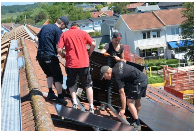
Figur 1. Bild från montering av solhybrider på Värlokens tak, juni 2013.
