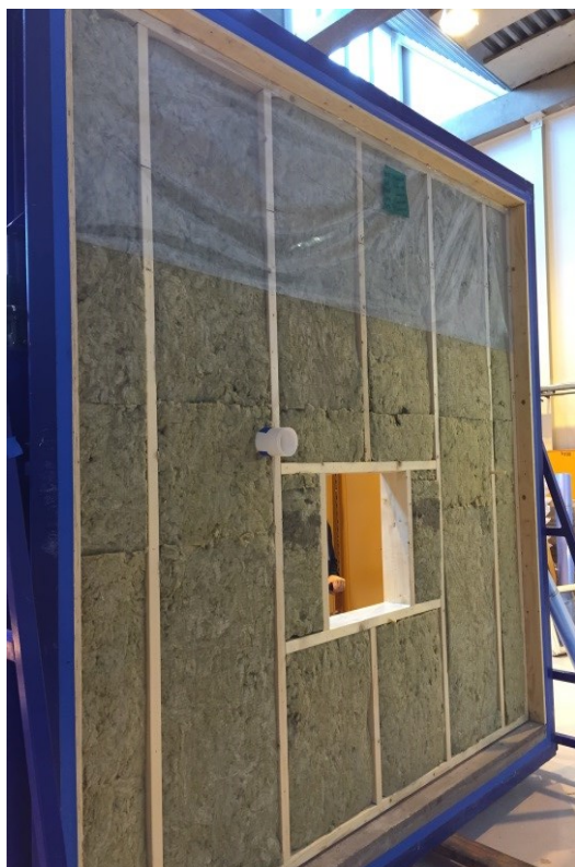
Bild 2. Montering av lufttätetsystem
