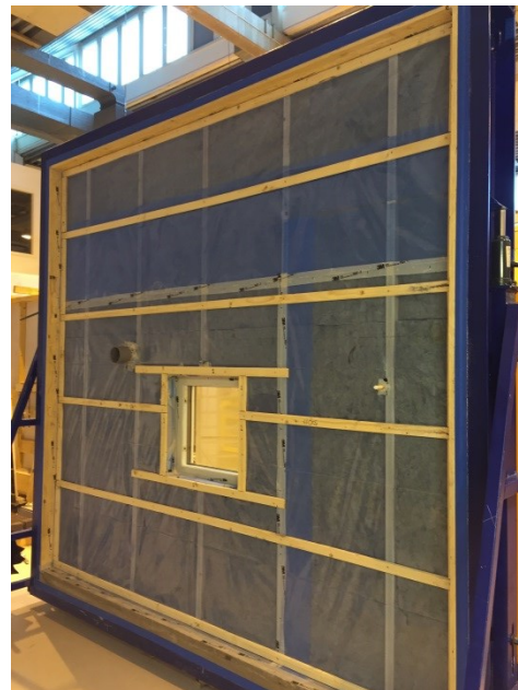
Montage av läkt som ersätter regler för ett installationsskikt, hela lufttätthetssystemet är monterat.
