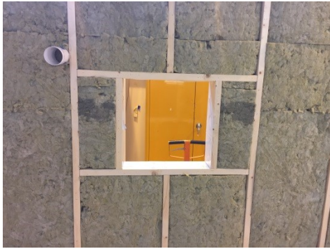
Montering av fönster och rör för ventilation
