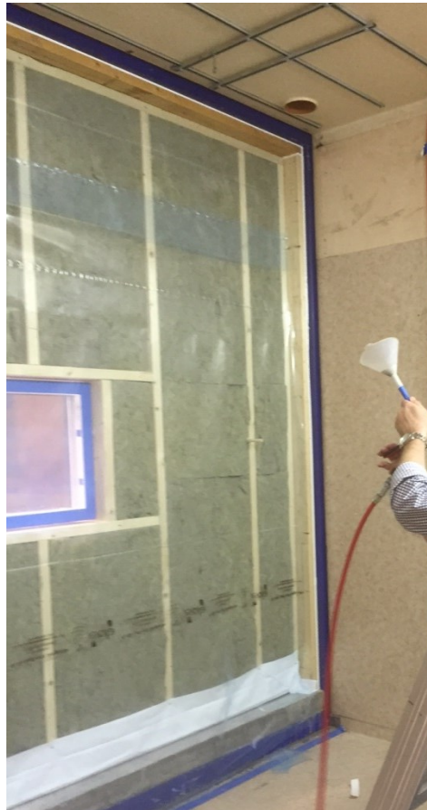
Konstgjort damm "sprutats" mot plastfolien
