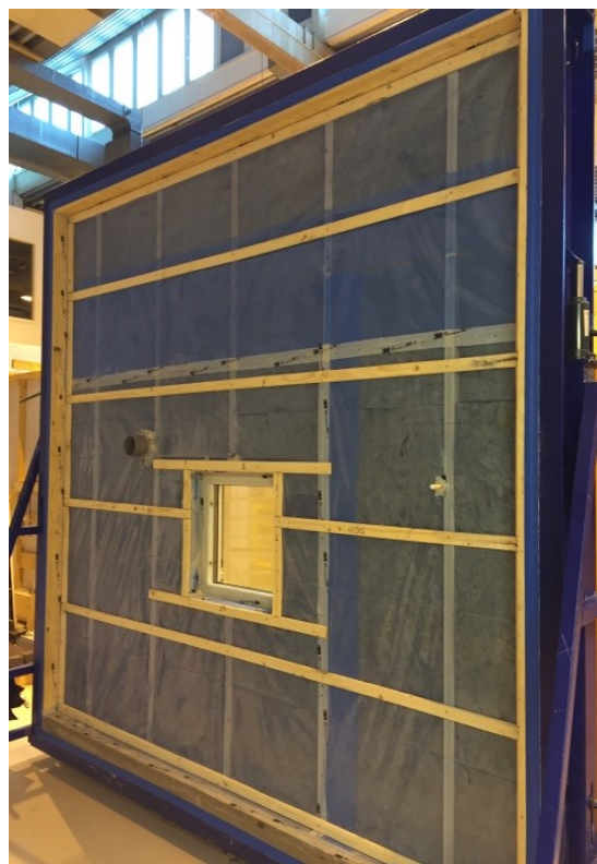
Bild 3. Lufttätetsystem färdigt för provning
