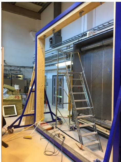
Bild 1. Provvägg under uppbyggnad
